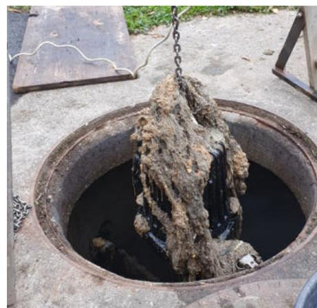
▲ Feuchttücher, die leider noch immer über das WC entsorgt werden, verursachen große Schäden an den Fäkalpumpen und erhöhen dadurch die Kanalgebühren.
