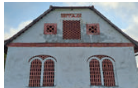
▲ Das Ziegelgitter in Nägelsdorf 3 wurde 1866 von Josef und Theresia Auer errichtet.
